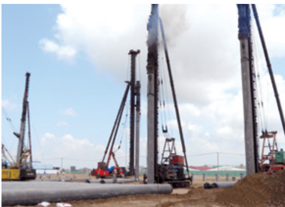
Thiết bị đóng cọc / Pilling rig Quantity: 06 units Capacity: 3.5T - 7.2T
