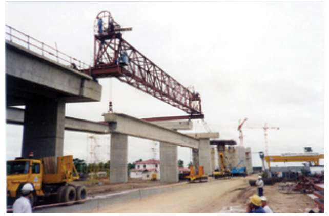
Dàn lao phóng dầm / Lifting Truss
