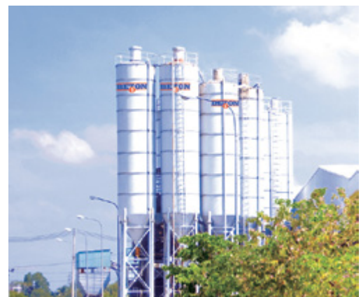
Trạm trộn bê tông / Mixer Plant
